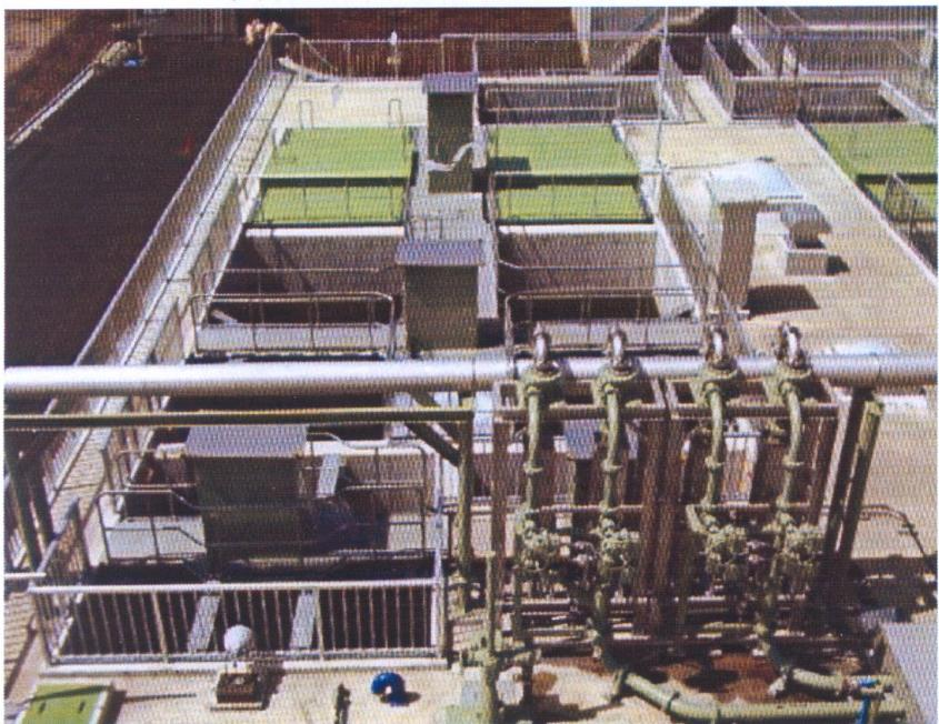
■多摩区生田にある生田浄水場の一画に、とてつもない「優れもの」が稼働している。超高速凝集沈でん池(写真左)だ。フランス生まれで、最新鋭の沈でん処理技術。4年前に導入されたが、もちろん日本初、いまも最大だ。今まで、日量20万トンの原水を処理するのに2時間13分の滞留時間を要したというのに、なんと18分という超スピード。
